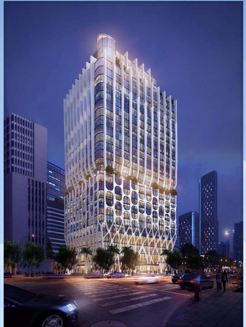
Dự án Techcombank Saigon Tower
